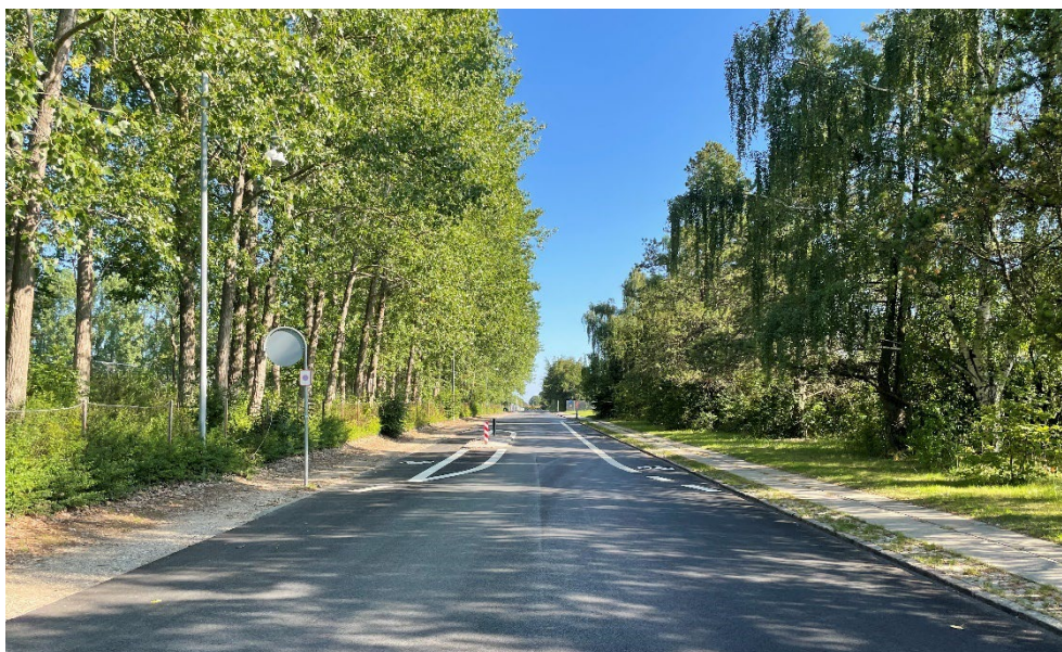
Hvissingevej er i begge retninger indrettet med eksisterende fortove. Til venstre ses den afskærmende beplantning som afgrænser boldbanerne ved Glostrup Fodbold Klub. Til højre ses det nordvestlige hjørne af lokalplanområdet.
