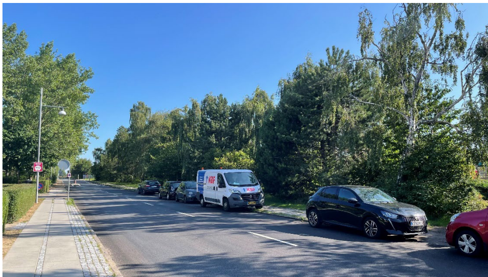
Lokalplanområdet set fra Hvissingevej mod nord. Området fremstår i dag afgrænset af blandet træer og buske således området visuelt er afskærmet mod Hvissingevej.
